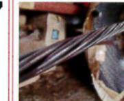
鉄筋の4倍の強度のワイヤーを撚って構成する
