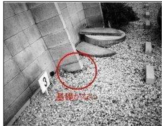
写真5 地震で倒れかかっている塀の被害例
