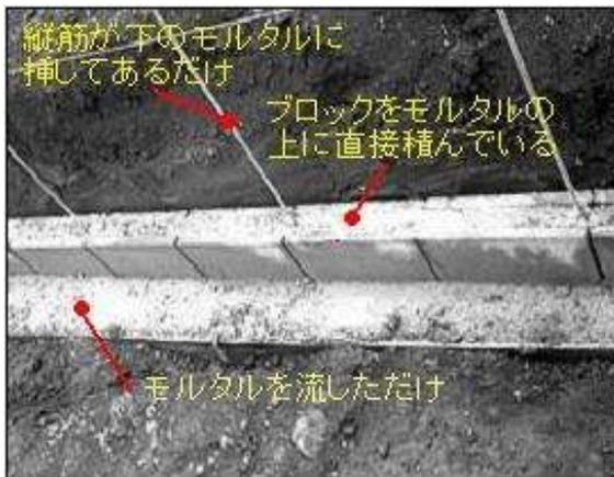
写真4 埋込み基礎の施工例
