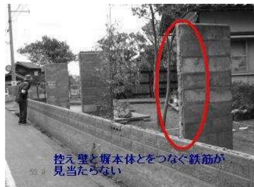
写真9 地震で塀本体が倒壊した例
