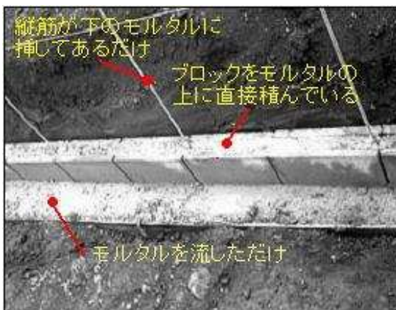
写真4 埋込み基礎の施工例
