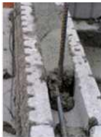
写真 7 基本形横筋ブロックのモルタル充填
